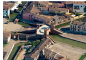
Ponte dei Trepponti - Comacchio
